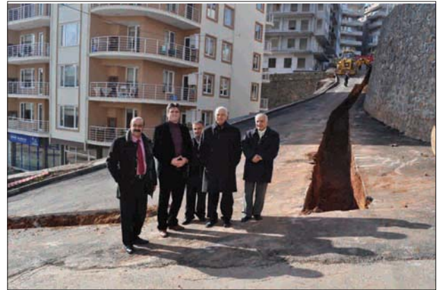
Elektrik Kabloları Yer Altına Alınıyor
