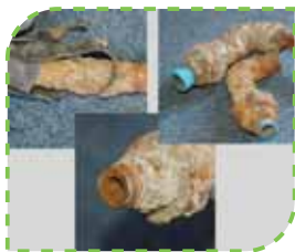
İçme suyu eski bağlantı boruları
