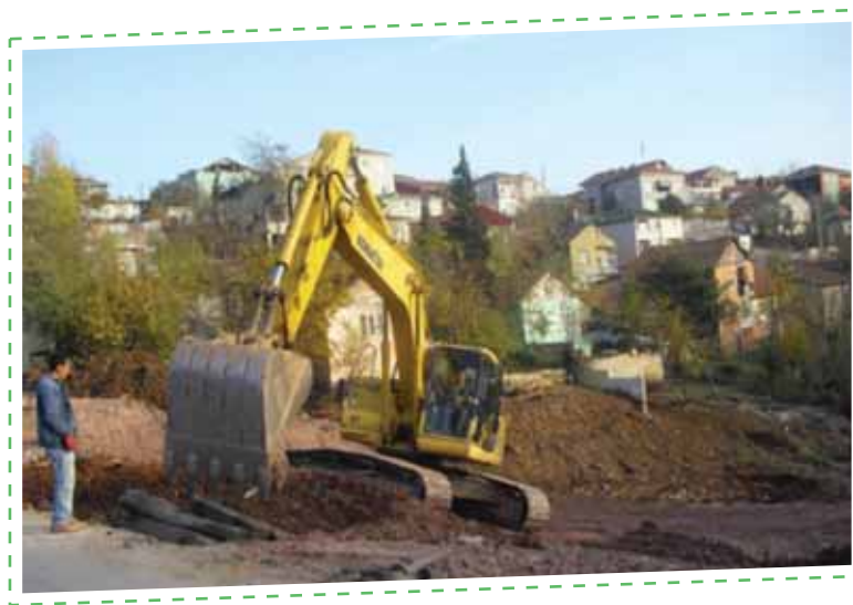
Cimbızdere Reglaj Çalışması ve Travers Merdiven Yapımı
