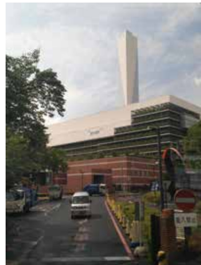
Itabashi Atık Yakma Tesisi
