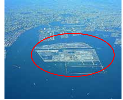
Katı Atık Düzenli Depolama Sahası Deniz Dolgusu
