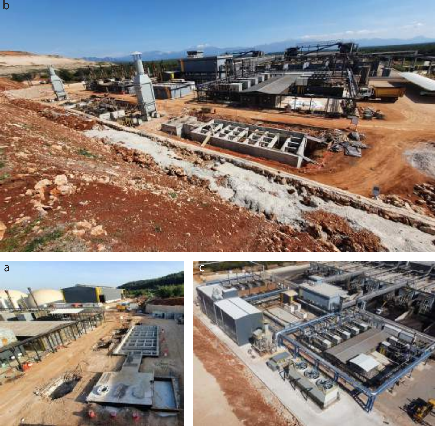
Şekil 3. WHR Tesisi Kurulumu a) Soğutma kulesi kurulumu b) Atık ısı kazanı kurulumu c) Tesis genel görünümü
